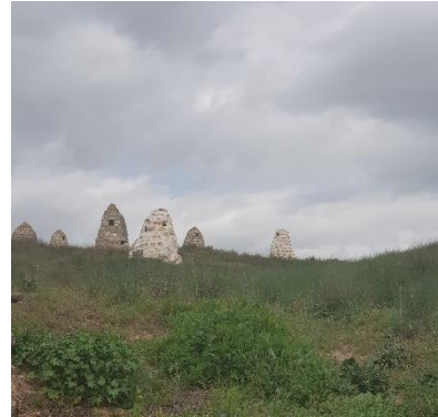
Figura 35. Detalle de las chimeneas de respiración de las bodegas subterráneas, denominadas "zarcas"
